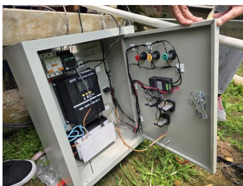
Gambar 2. Instalasi Sistem PV di Rumah Tanam Hidroponik
