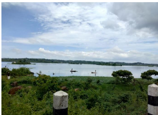
Gambar 2. Penampakan Bendungan Pandan Duri secara langsung
