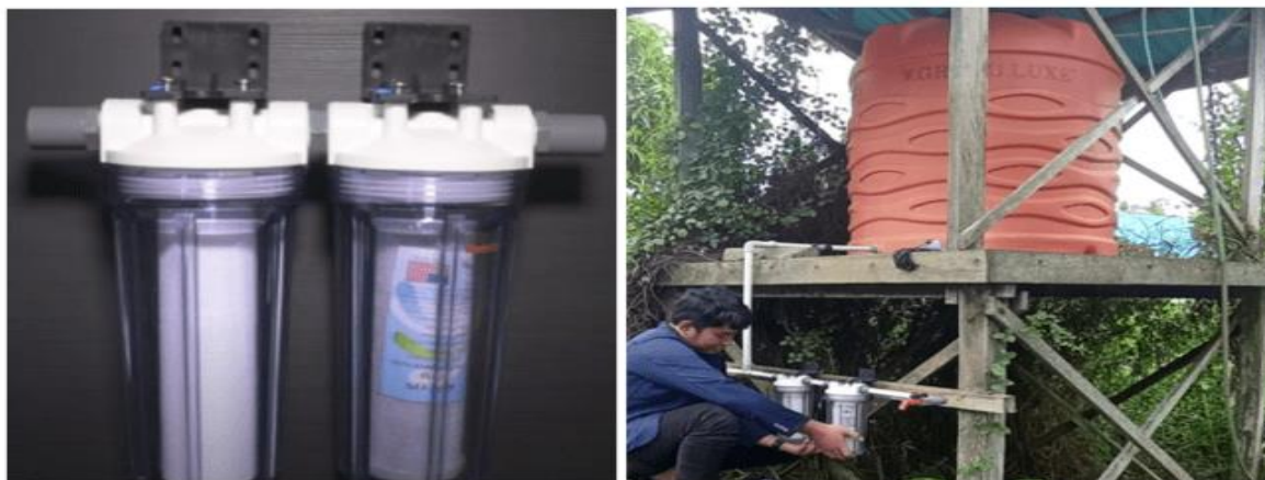
Gambar 3. Pemasangan alat filter air ke Tandon air yang ada diDesa
