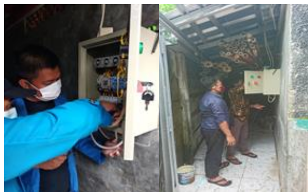
Gambar 3. Pemasangan Panel ATS
