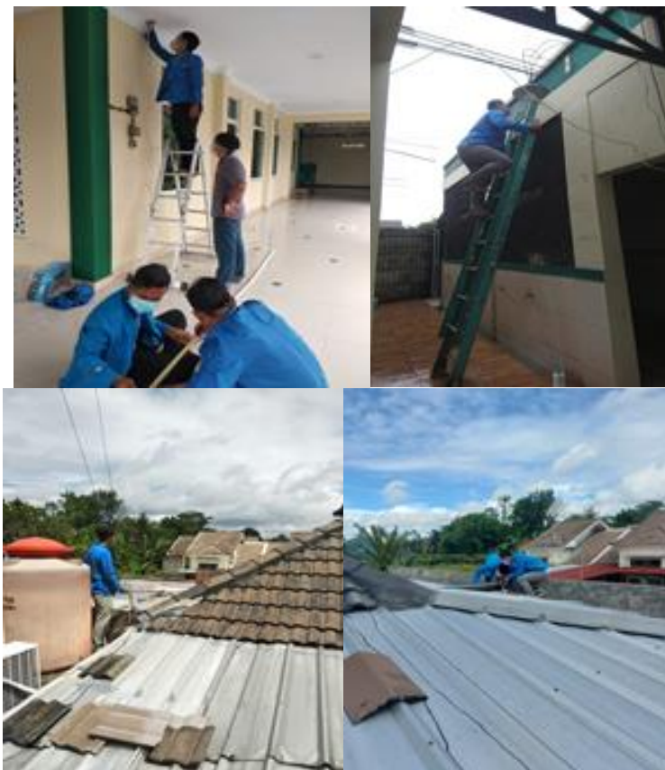
Gambar 4. Proses Penarikan Jalur Kabel
