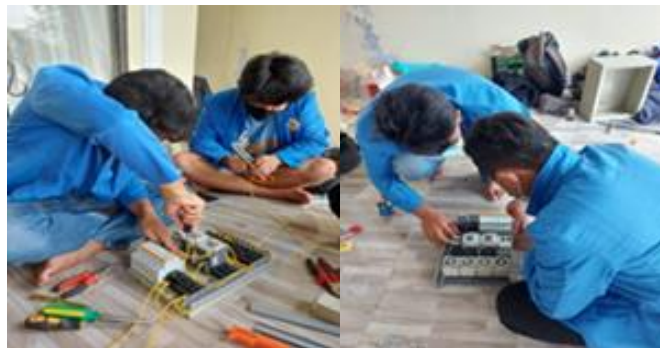
Gambar 2. Perakitan Panel ATS
